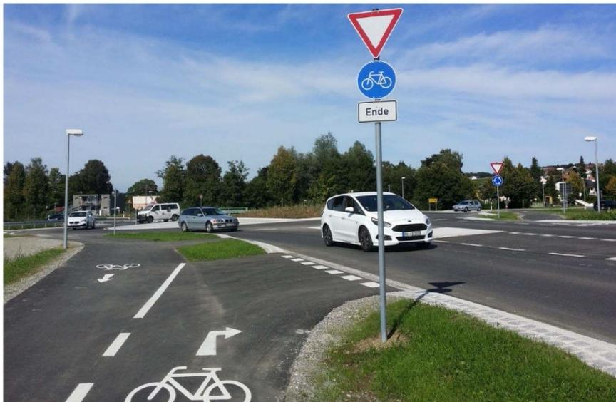
Bild 2: Höhengleiche Fahrbahnquerung eines Radweges [Quelle: topplan 2020]
